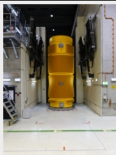
Im Wartungsbereich des Zwischenlagers (Kalthantierung) Download
