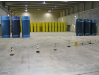
Östliche Hallenhälfte mit CASTOR®-Behältern
