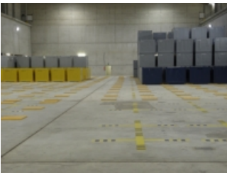
Westliche Hallenhälfte mit Abfallbehältern
